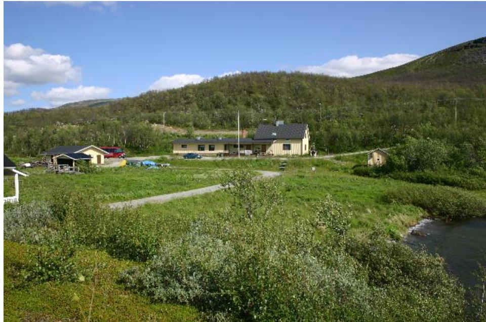
Kuva 24. Metlan Kilpisjärven tukikohta.
