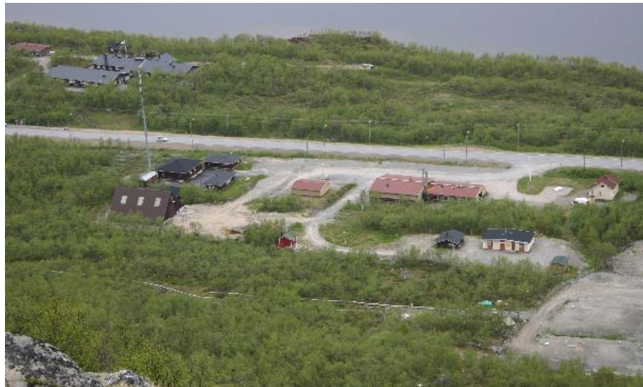
Kuva 28. Entisen tielaitoksen pihapiiri
